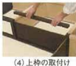
(4) 上枠の取付け
