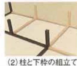
(2) 柱と下枠の組立て
